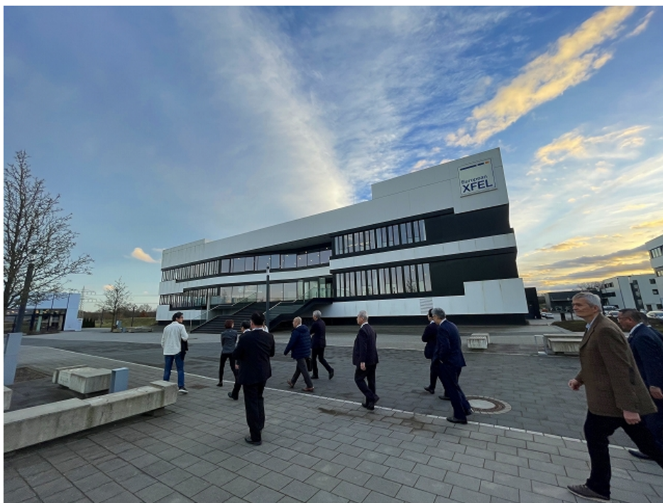
DESY XFEL外観
