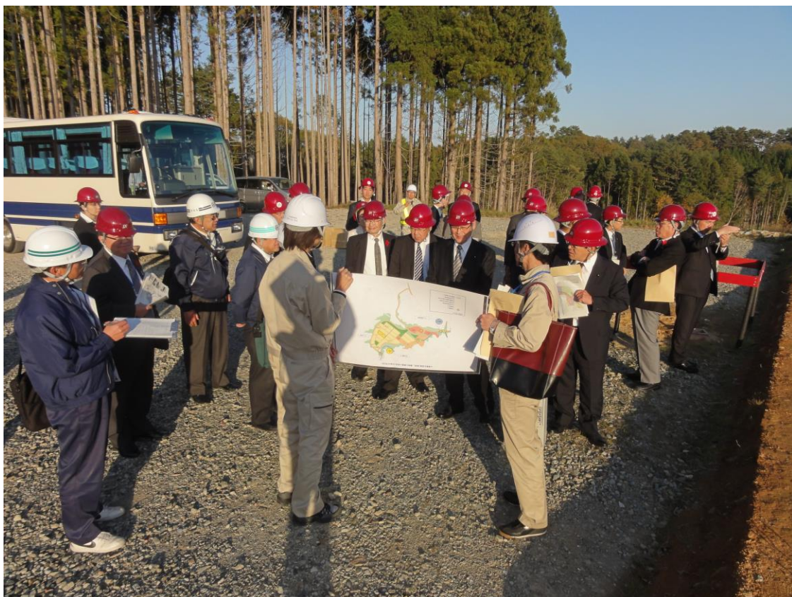
防災集団移転促進事業工事現場（宮古市）
