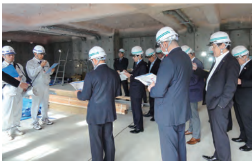
（災害公営住宅（花巻中央地区）での様子）
