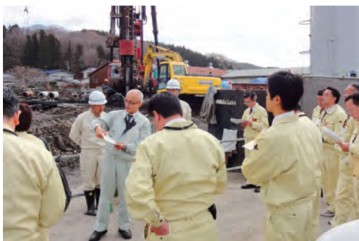
（久慈市漁協製氷・貯氷施設建設現場での様子）
