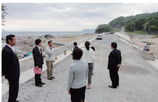
（明戸地区震災遺構保存整備現場での様子）
