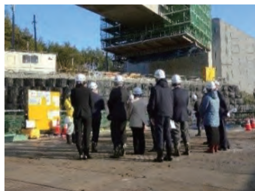
((仮称) 新思惟大橋工事現場での様子)
