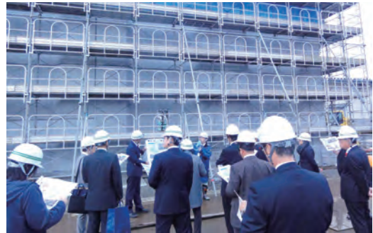
(鉾ヶ崎地区海岸保全施設での様子)
